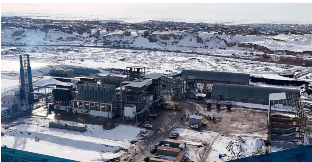
Рис. 5. Завод по вторичной переработке свинцовых отходов ТОО «Standard Steel KZ» (фото из открытых интернет-источников)
