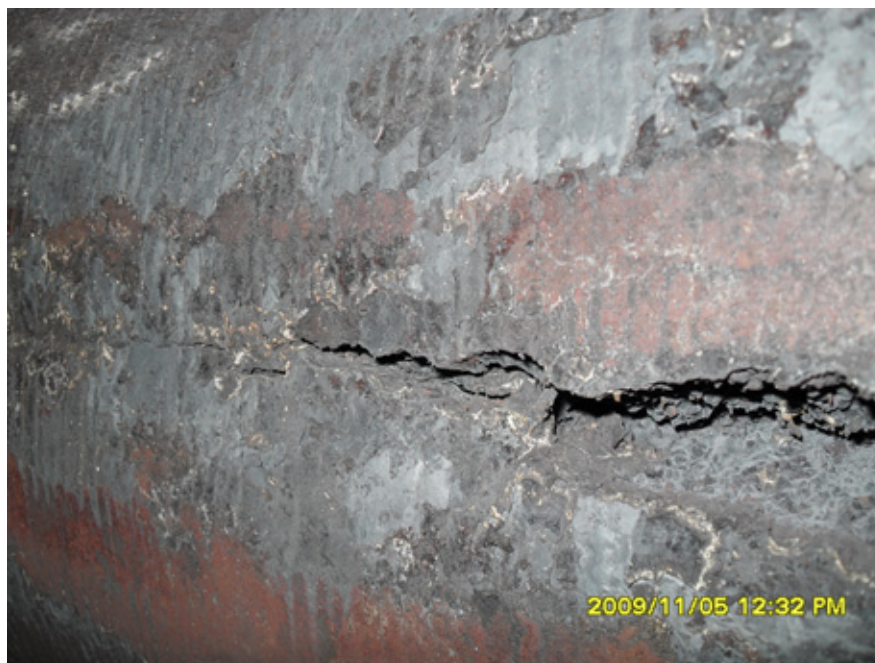
Рис. 5. Продольная трещина
