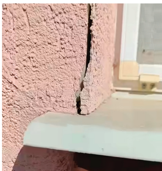
Рис. 4. Несоответствие качества армирующей сетки
