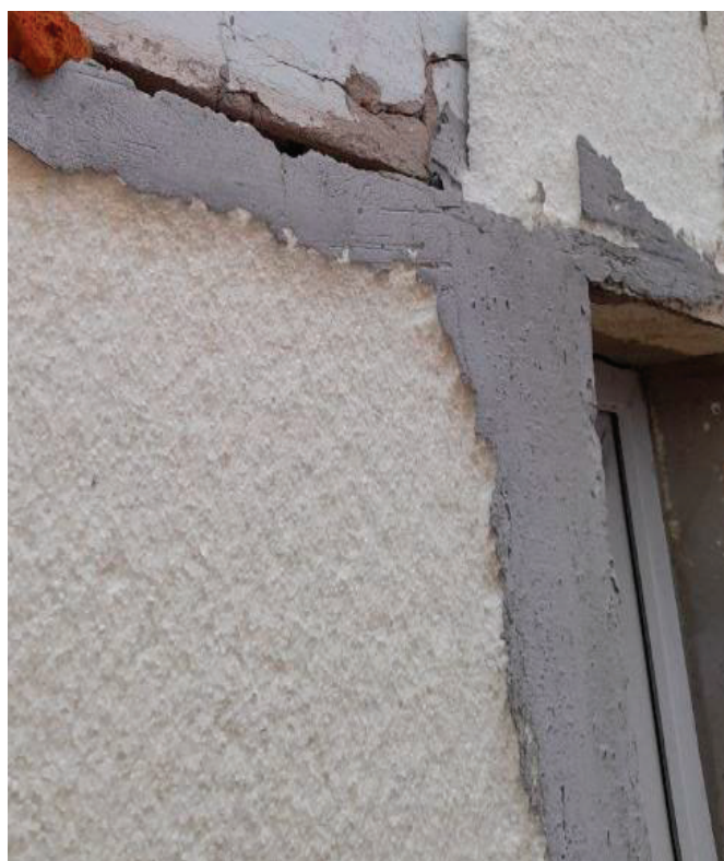
Рис. 6. Разрушение плитного теплоизоляционного материала в виде пенополистирола в результате ультрафиолетового воздействия
