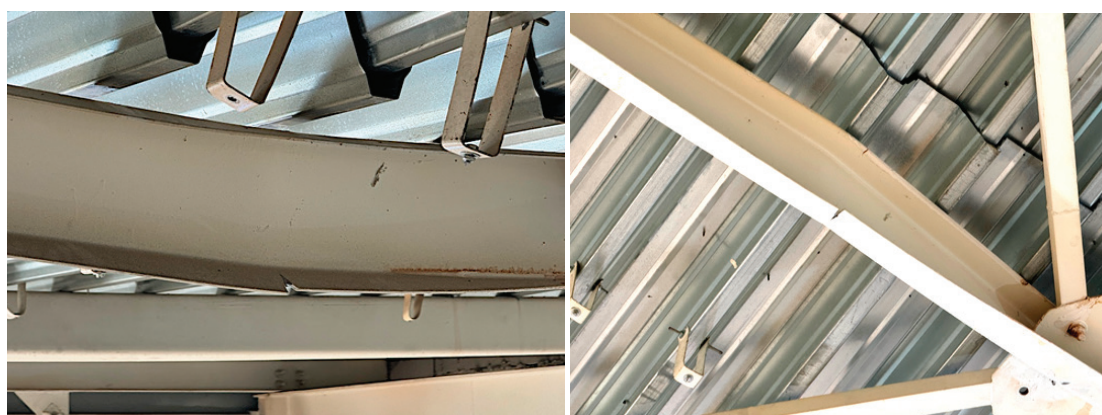
Рис. 3. Деформация подкровельных конструкций здания
