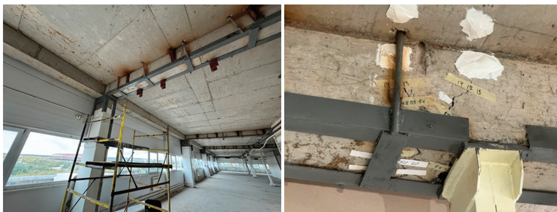
Рис. 2. Усиленные железобетонные балки здания
