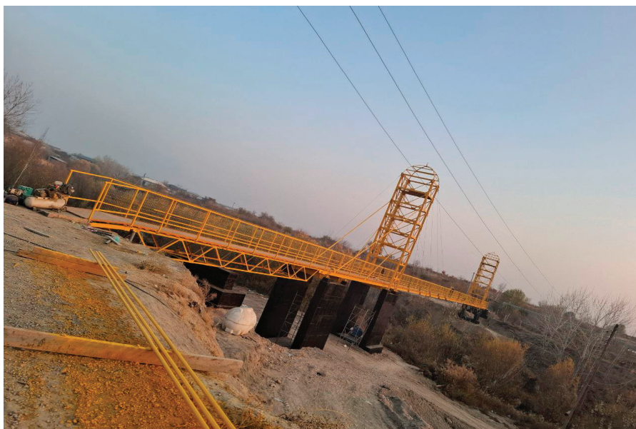
Рис. 8. Мост на улице Иджодкор (101 м)
