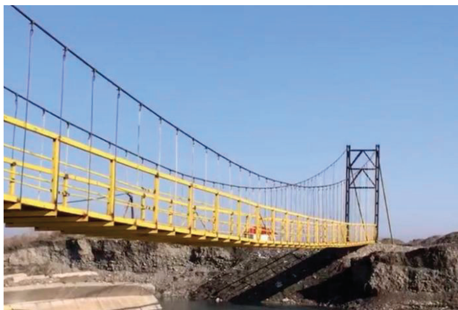
Рис. 9. Висячий мост через реку Ок Дарья (50 м)
