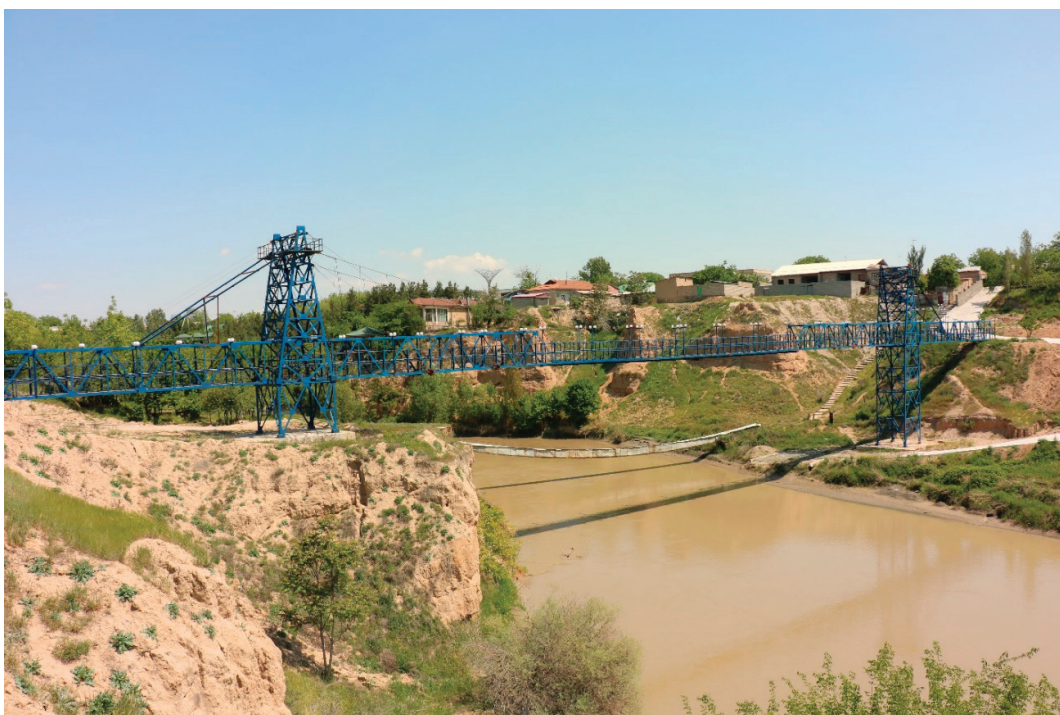
Рис. 7. Мост через канал Даргом (132 м)
