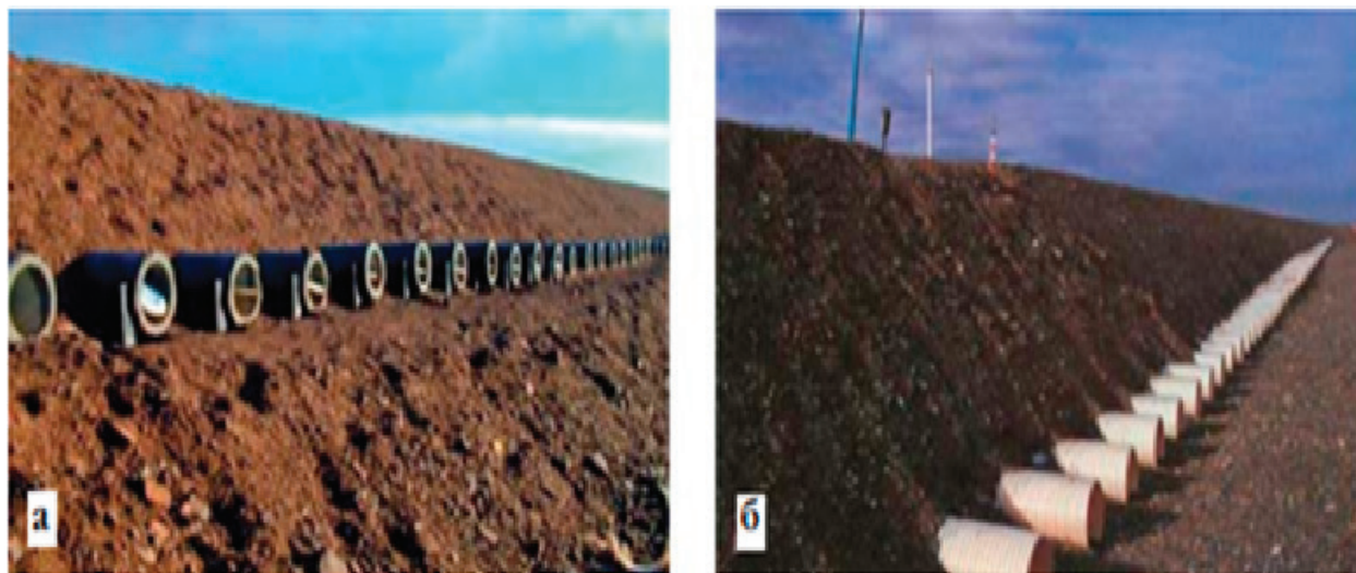
Рис. 2. Поперечные вентилируемые трубы в основании земляного полотна Цинхай-Тибетской ж. д. на участках ладистых грунтов: а — пластиковые, б — железобетонные, автоматически закрывающиеся крышками (фото профессора Нью Фуджина)
