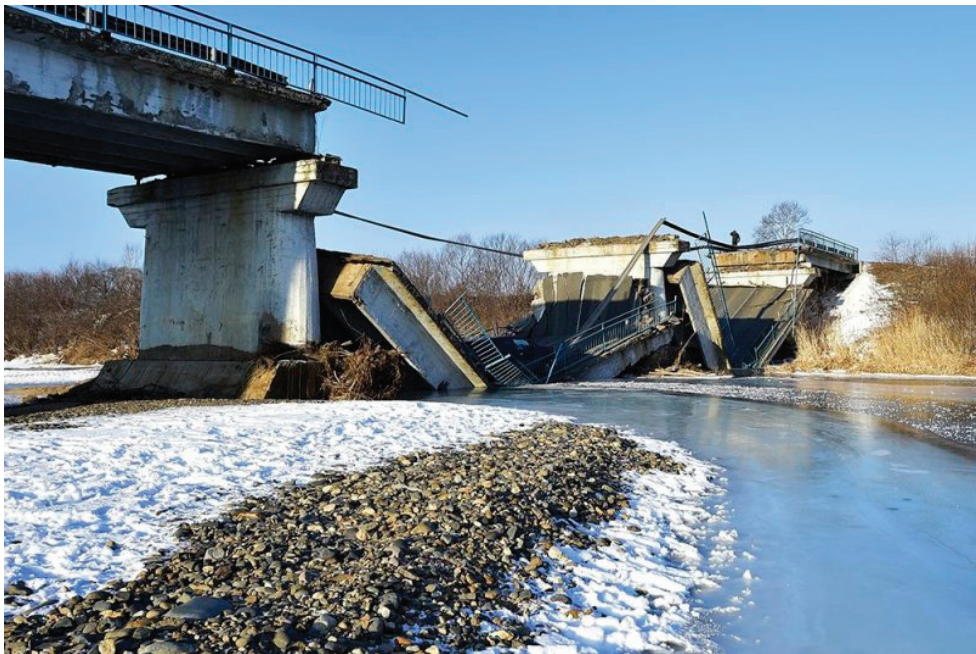
Рис. 1. Разрушенный автомобильный мост, п. Новолитовск
