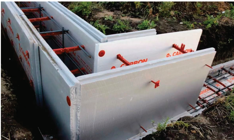
Рис. 2. Несъемная опалубка из пенополистирола
