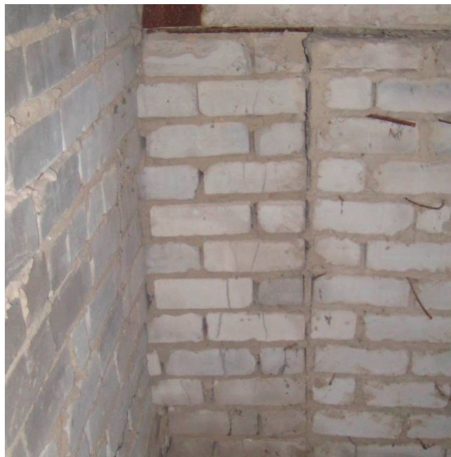
Рис. 6. Вертикальные трещины в кирпичных пилястрах и столбах, расположенных на тех. этаже здания
