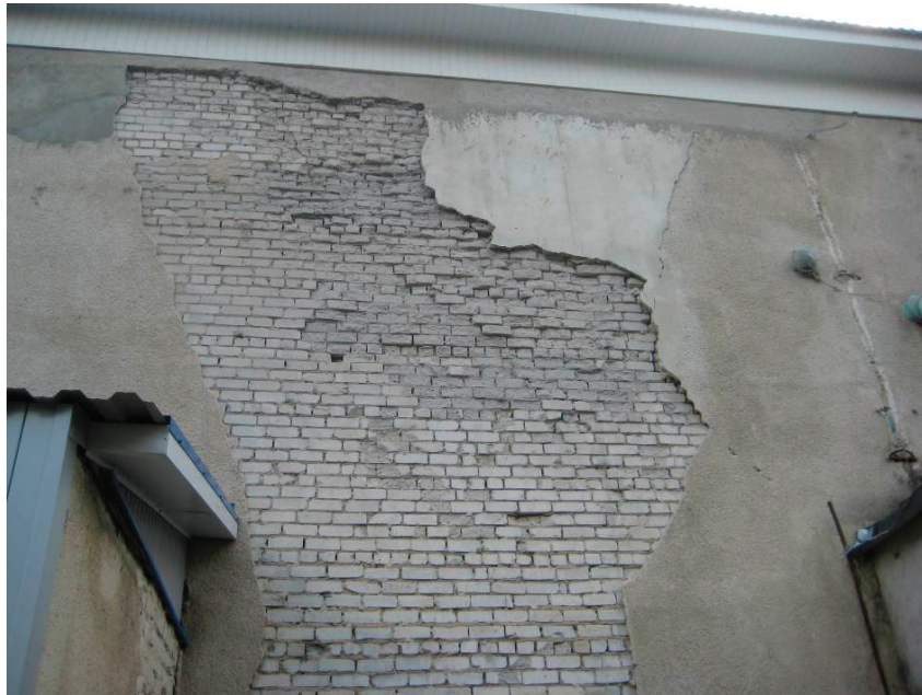
Рис. 5. Обрушение штукатурного покрытия, разрушение кирпича лещадками на глубину до 15 мм наружной стены здания
