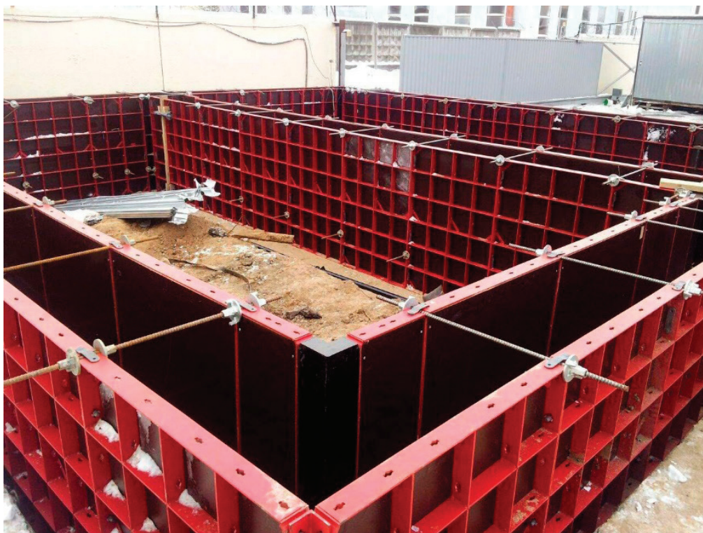
Рис. 1. Съемная опалубка
