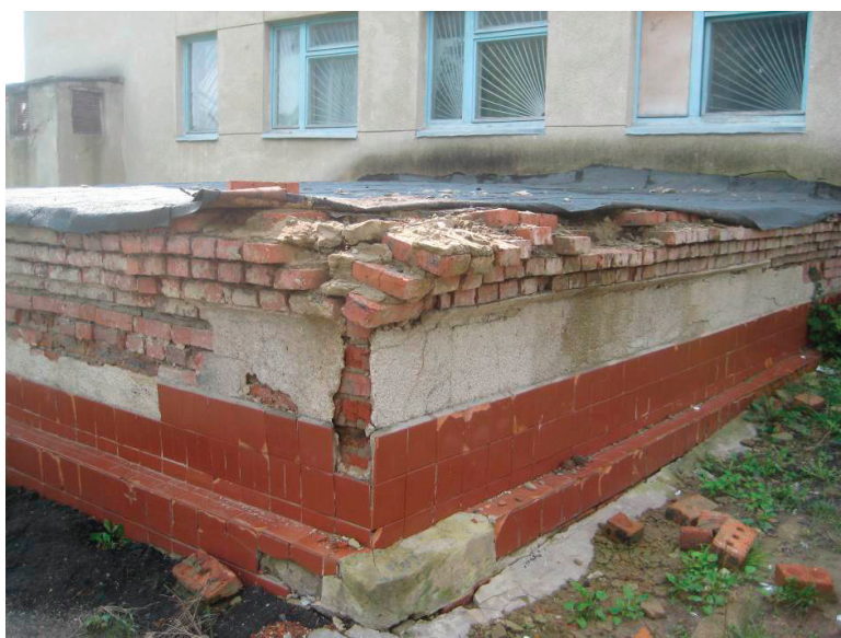
Рис. 3. Разрушение гидроизоляционного покрытия и кирпичной кладки надземных стен насосной здания
