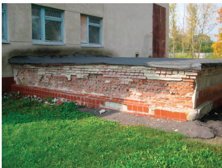
Рис. 4. Разрушение лещадками кирпичной кладки надземных стен насосной здания
