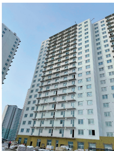
Рис. 1. Пример применения минерал-ватных плит и теплоизоляционной штукатурки, г. Мурино, ЖК «Цветной город» (фото автора)
