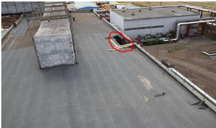
Рис. 1. Общий вид аварийного обрушения плиты покрытия III очереди строительства котельной на участке в осях «3-4, К» (вид сверху)
