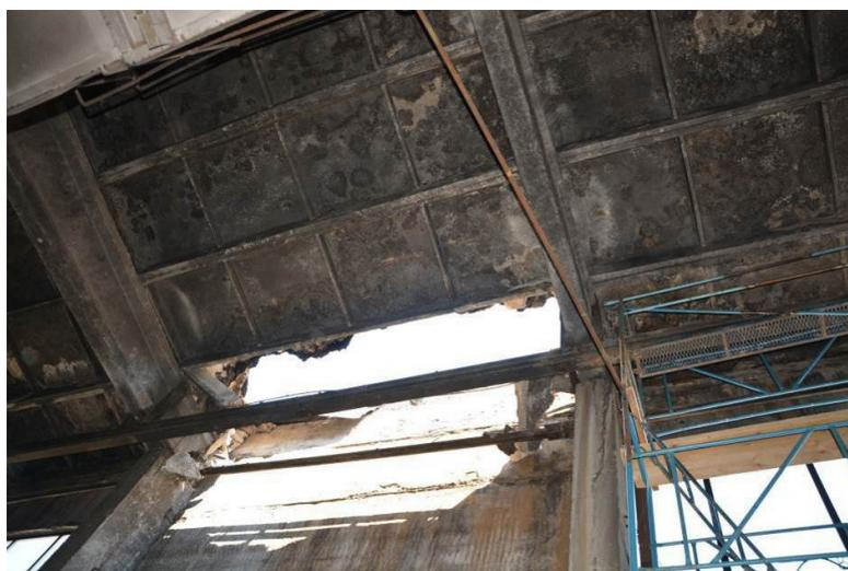
Рис. 2. Общий вид аварийного обрушения плиты покрытия III очереди строительства котельной на участке в осях «3-4, К» (вид изнутри)
